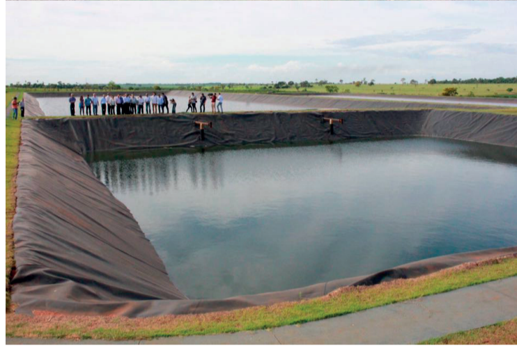
Estação de Tratamento de Esgoto (ETE) do município possui capacidade de tratar 13,5 litros de efluentes por segundo
